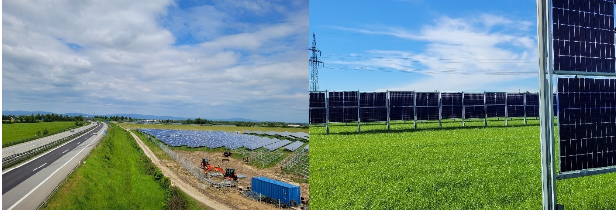
Abb. 2: Freiflächen-PV-Anlagen entlang von Autobahnen sowie bestimmte Agri-PV-Anlagen sind in vielen Fällen baurechtlich privilegiert (Fotos: C.A.R.M.E.N. e.V.).
