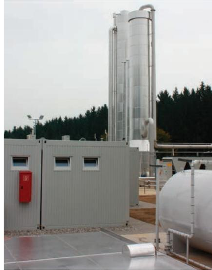
Abbildung 6: Druckwasserwäsche
