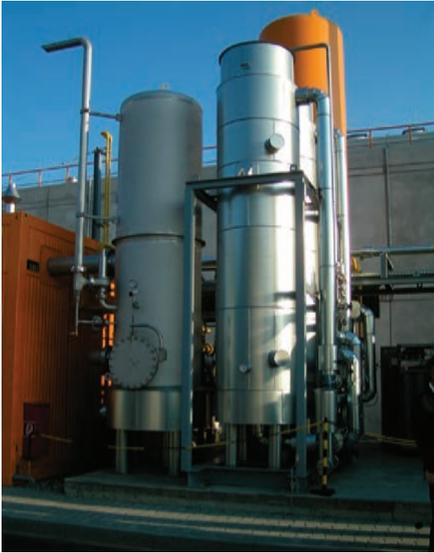
Abbildung 5: Druckwechsladsorption bzw. PSA (Pressure Swing Adsorption)
