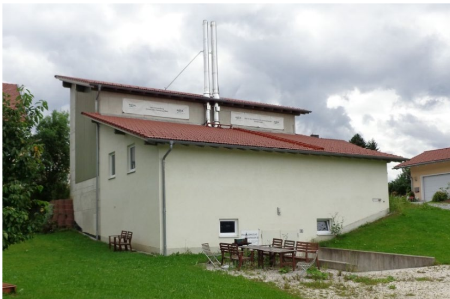
Heizwerk in Kaikenried
