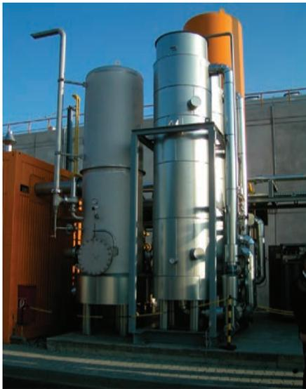
**Abbildung 5: Druckwechseladsorption bzw. PSA (Pressure Swing Adsorption)**
