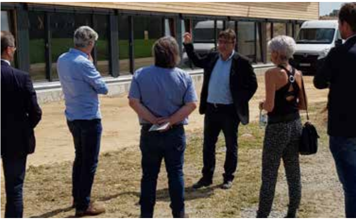
Architekt Karlheinz Beer (Mitte) führte die Interessierten über die Baustelle.
