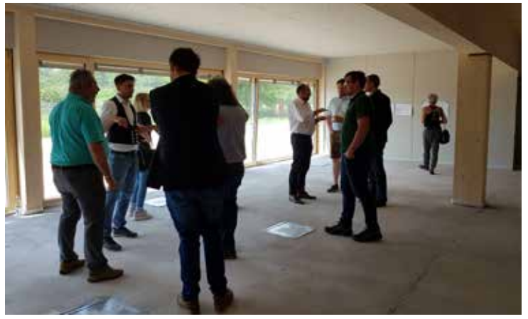
Die Baustelle konnte von den Besuchern komplett begangen werden. Gruber Projektleiter erklärten technische Details und beantworteten alle Fragen.
