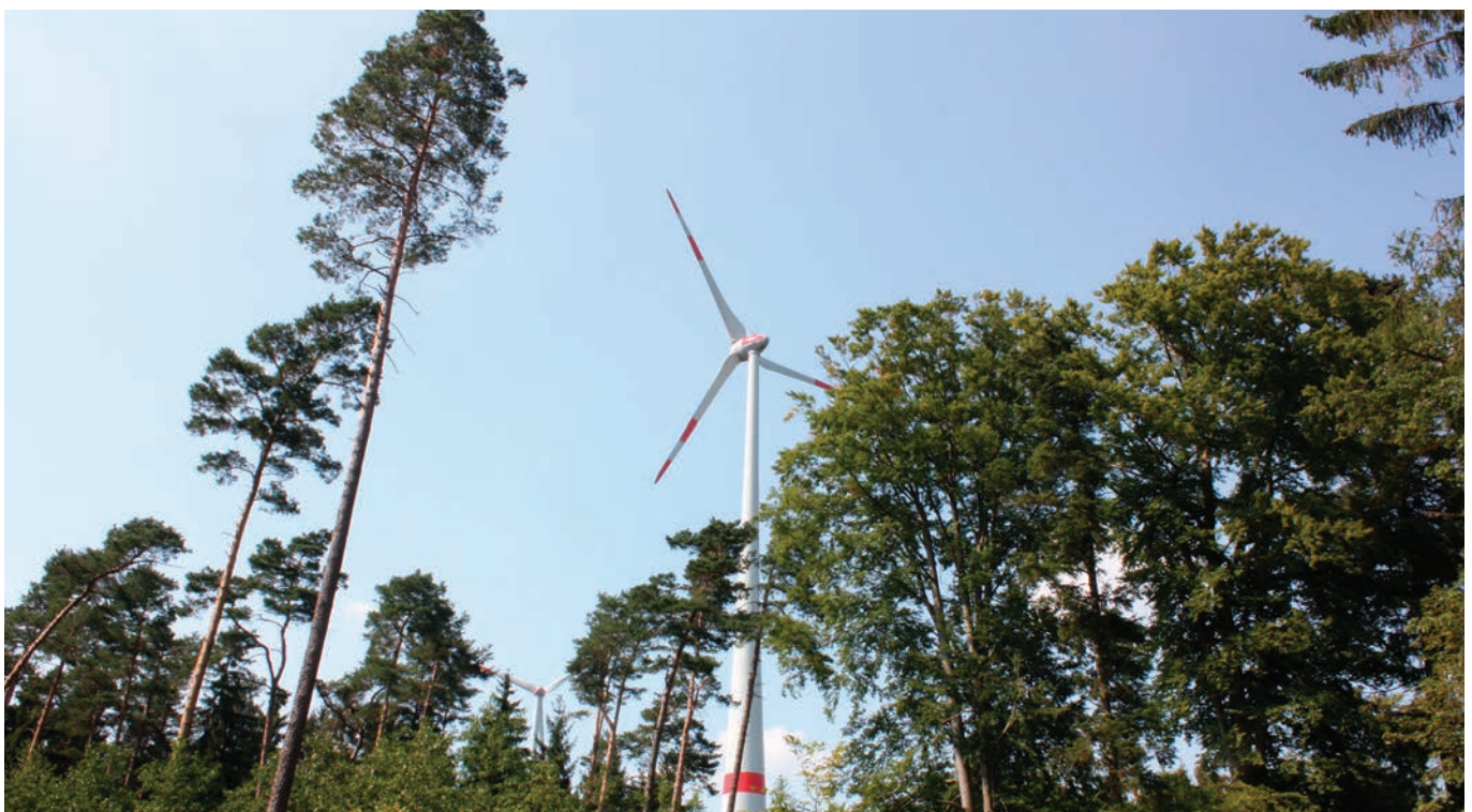
Abb. 5: Waldwindpark bei Dürrwangen in Mittelfranken
