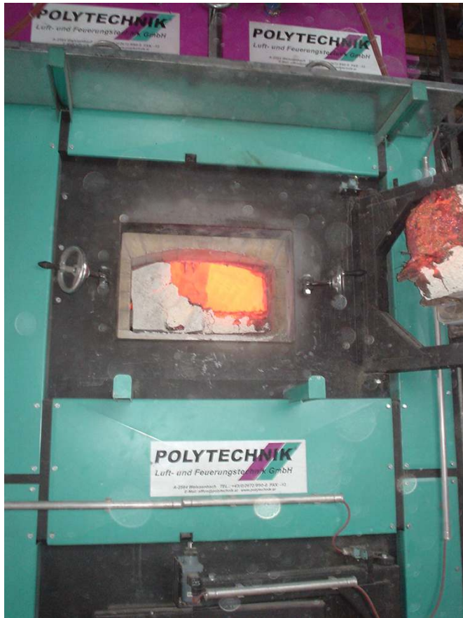
Schlackenbildung im Brennraum, Ascheklumpen
