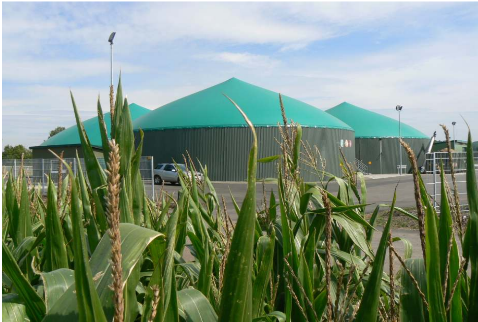
Biogasanlage Bad Königshofen
