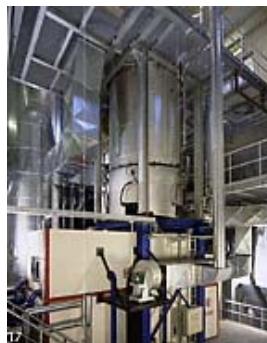
Bild 7: Heizkraftwerk Sauerlach mit Betriebsgebäude (links), Thermoölkessel (Mitte) und ORC-Modul (rechts) (Quelle: IB Gammel, Turboden)
