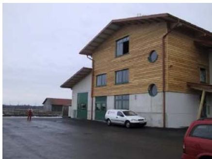
Bild 7: Heizkraftwerk Sauerlach mit Betriebsgebäude (links), Thermoölkessel (Mitte) und ORC-Modul (rechts) (Quelle: IB Gammel, Turboden)
