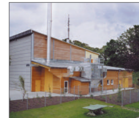
Im BHW Zwiesel wird ausschließlich naturbelassene Biomasse genutzt ④
