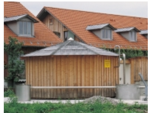
Biogasanlage – Gasdom
