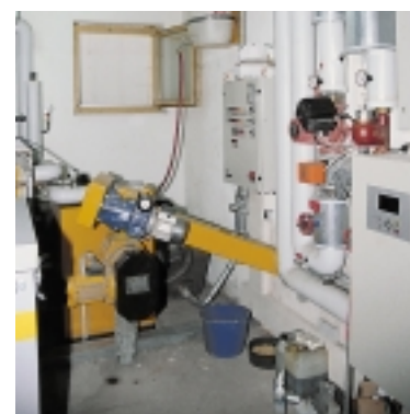
Hackgutförderschnecke mit Steuerung
