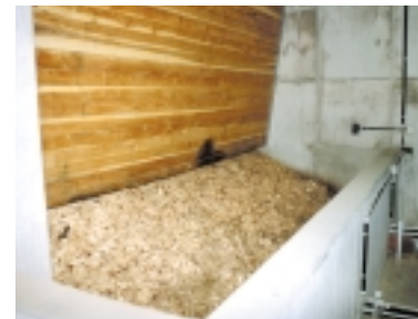
Hackschnitzelfördereinrichtung
