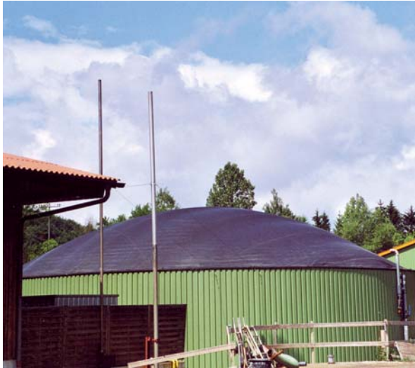
Biogasanlagenfermenter mit Gashaube
