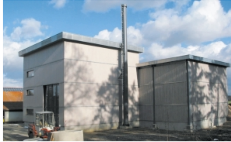
Heizwerk und Schnitzellager
